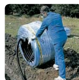
Leveret i de rigtige mål, og lagt ned direkte fra rullen.
